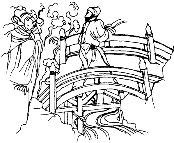
图 1-6 山西洪洞水神庙元代壁画中的木桥
