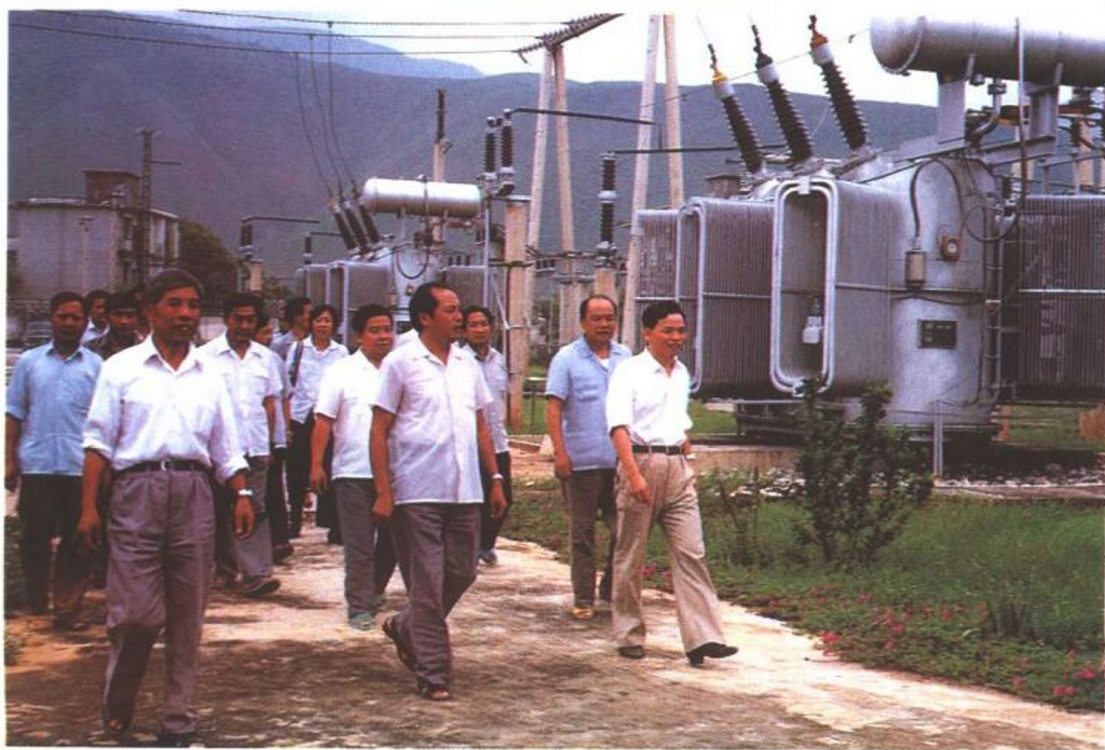
县领导参观升压站
