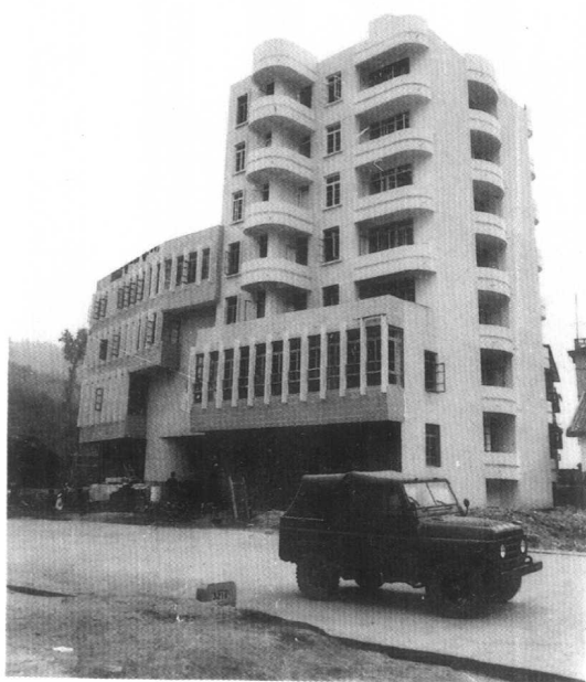
从江县建筑公司承建的县档案馆大楼
