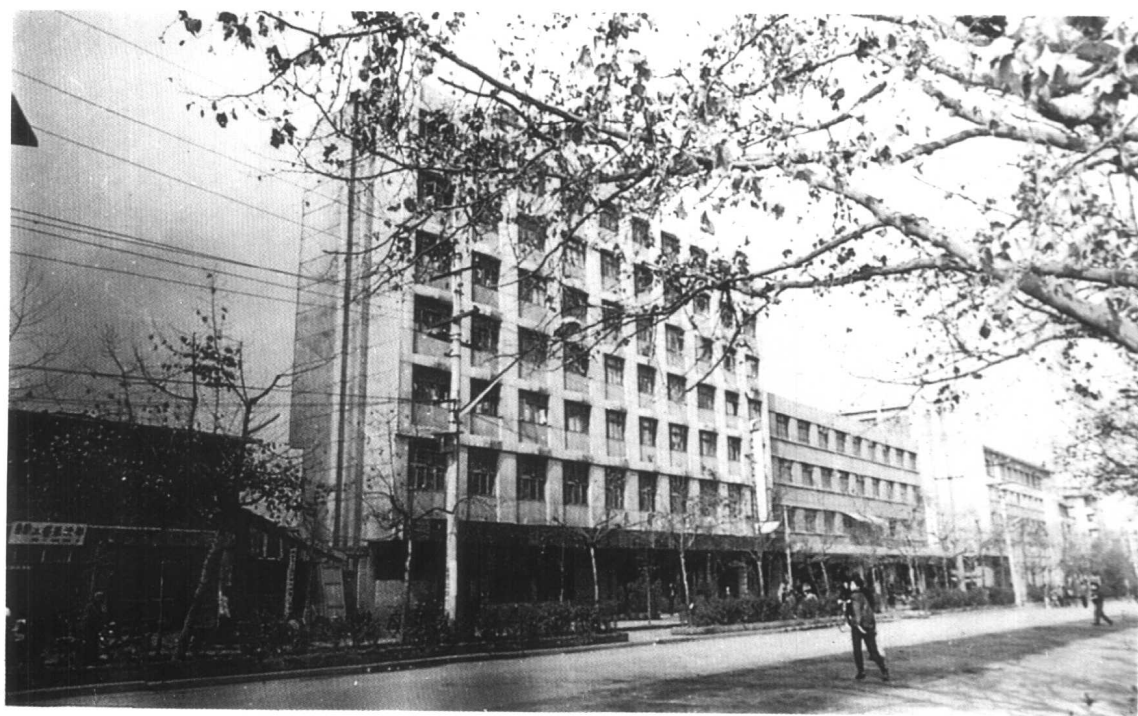
州乡镇企业局综合大楼及办公楼
