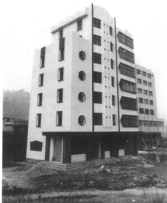
从江县乡镇企业局建筑队承建的房屋工程
