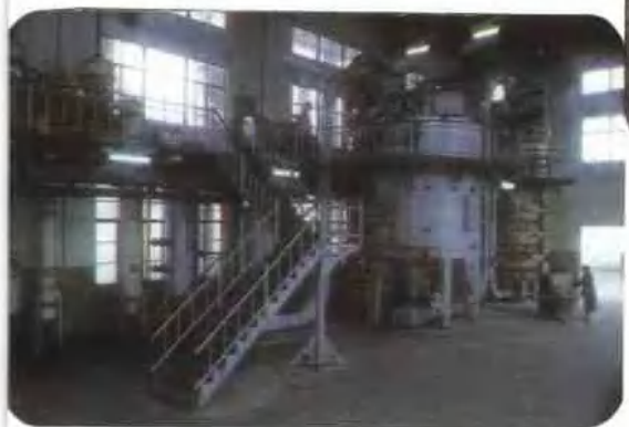
樟樹糧油公司浸出油車間
