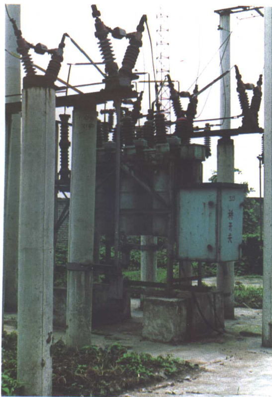
沙坪变电站35KV主接线及配电装置
