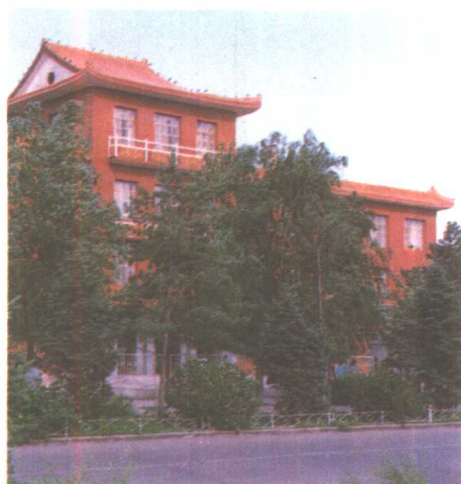
修复后的自治区人民政府原办公楼
