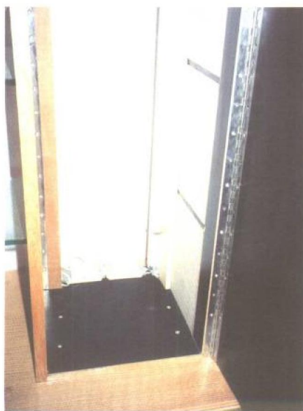
图1-10 把陈列柜中间的柜柱掩门打开，拉出内柜后所见的情形。右边的灯板已翻开，这样即可在柜内更换光管。由柜内侧可见到玻璃层板伸入柜柱。
