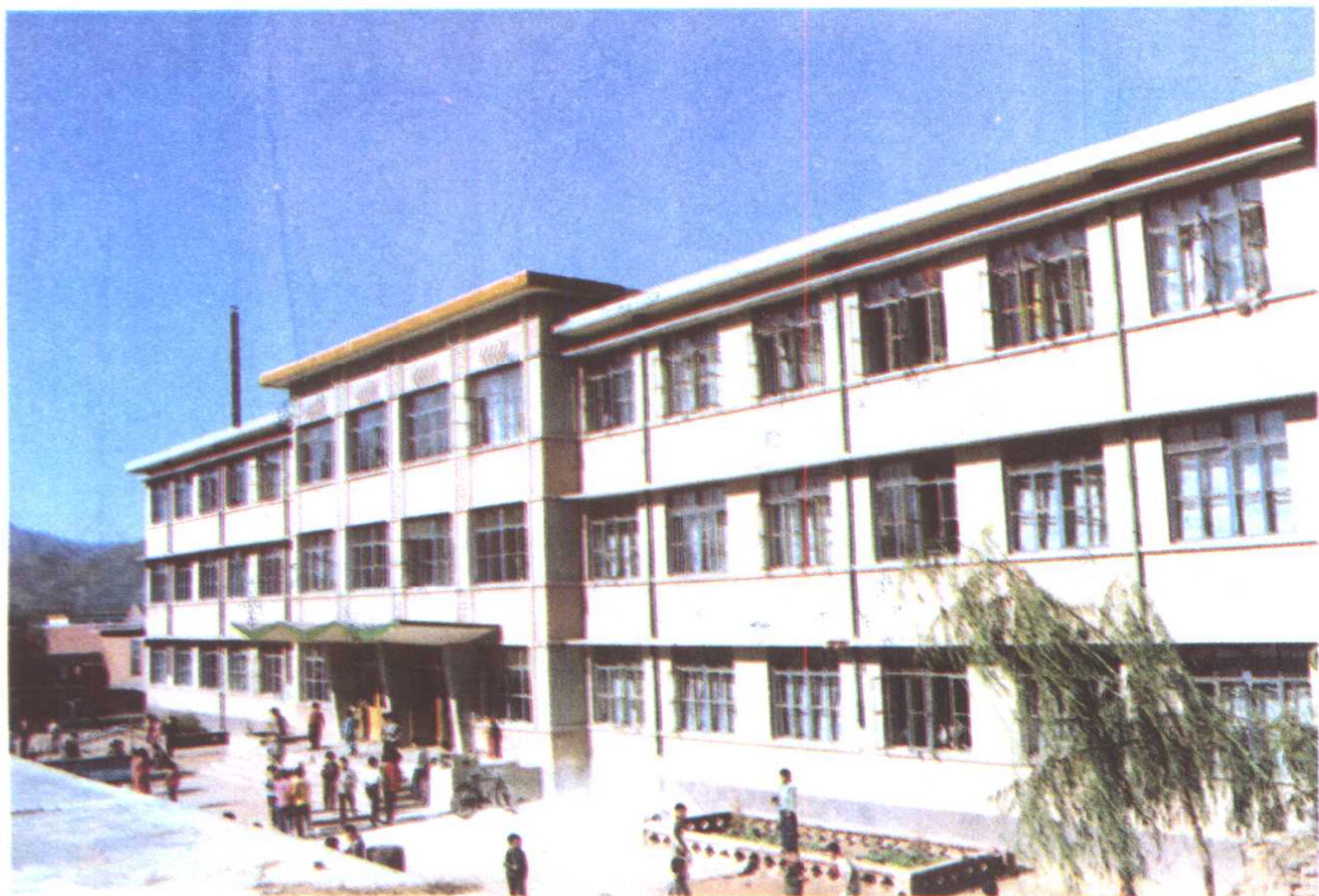
第一小学教学楼
