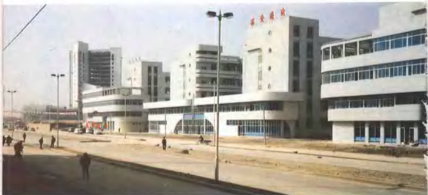
正在建设中的西安高新技术产业开发区
