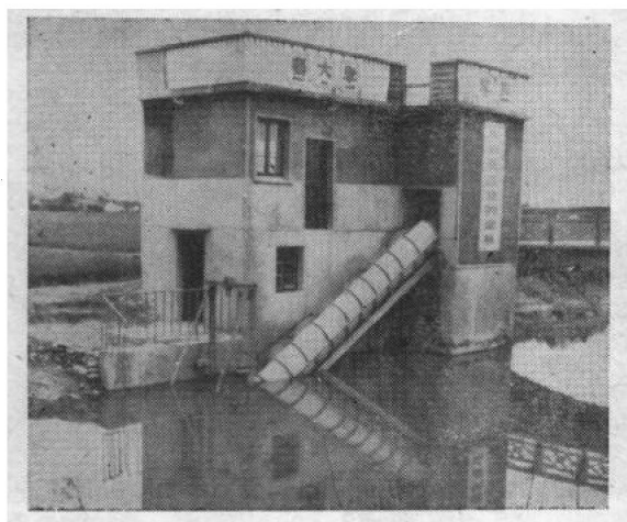
图 1-3 农业灌溉用螺旋泵
