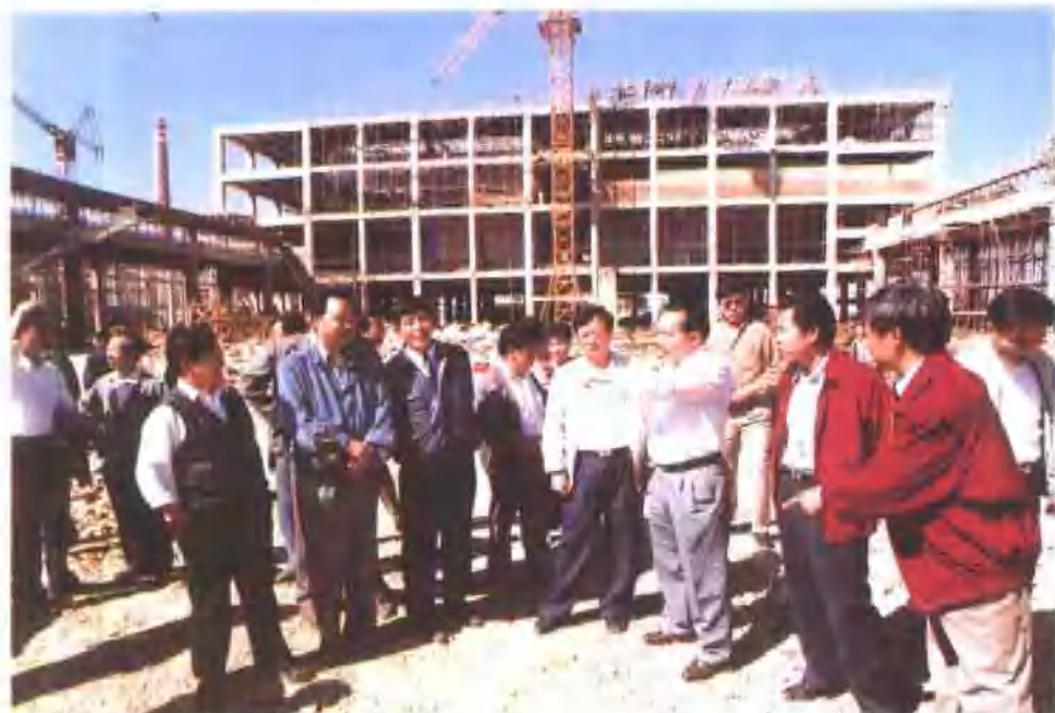
副省长李嘉廷在行署专员李兵等陪同下视察曲靖卷烟厂技改工地
