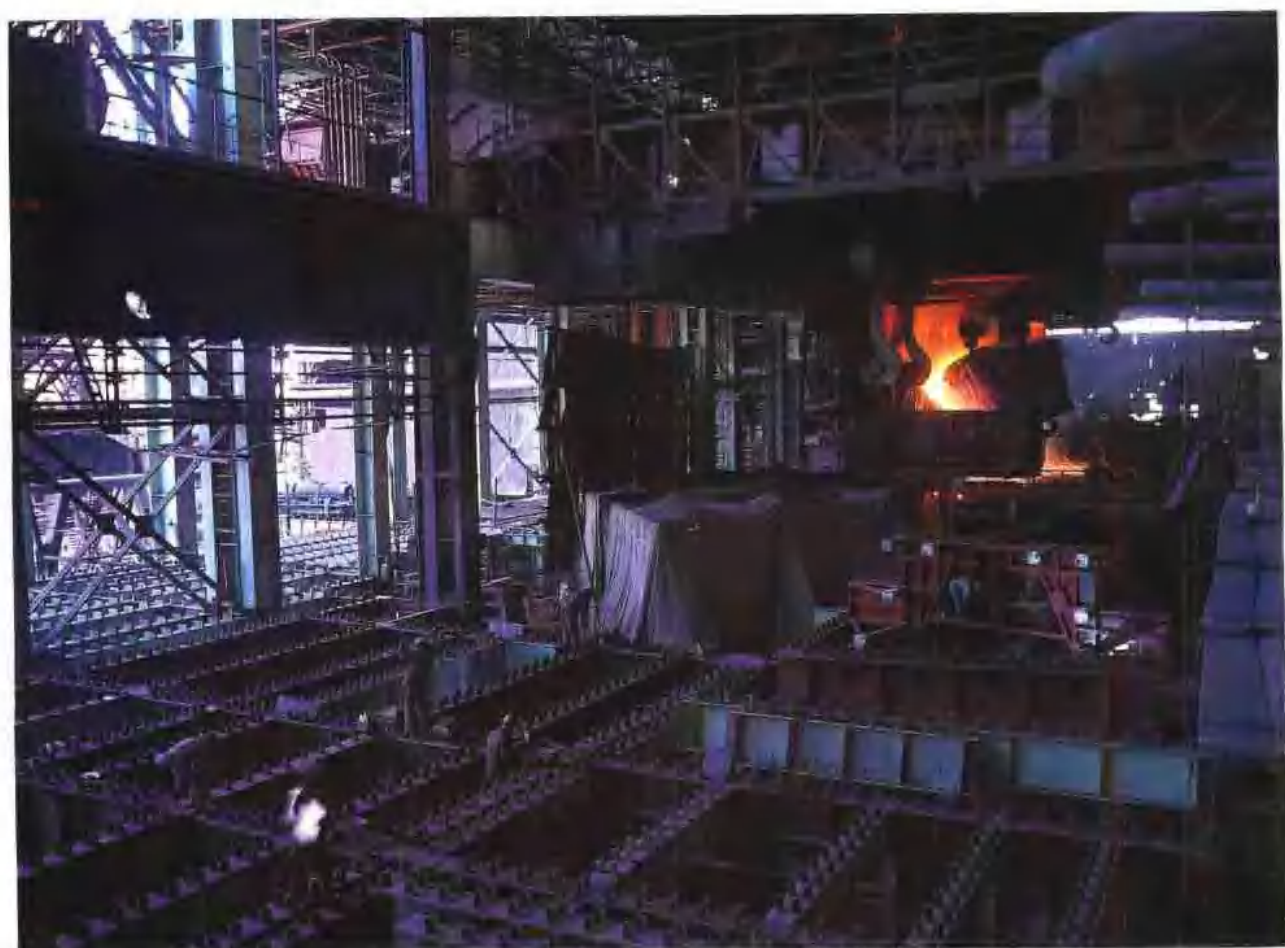
第三炼钢厂三号转炉改造工程
