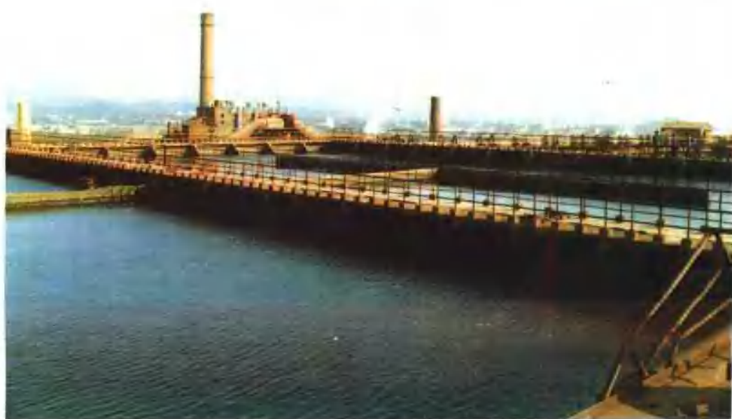
给水厂第六水站 南山贮水槽
