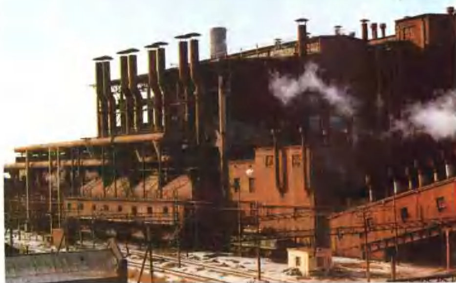
烧结总厂三烧车间 机尾电除尘
