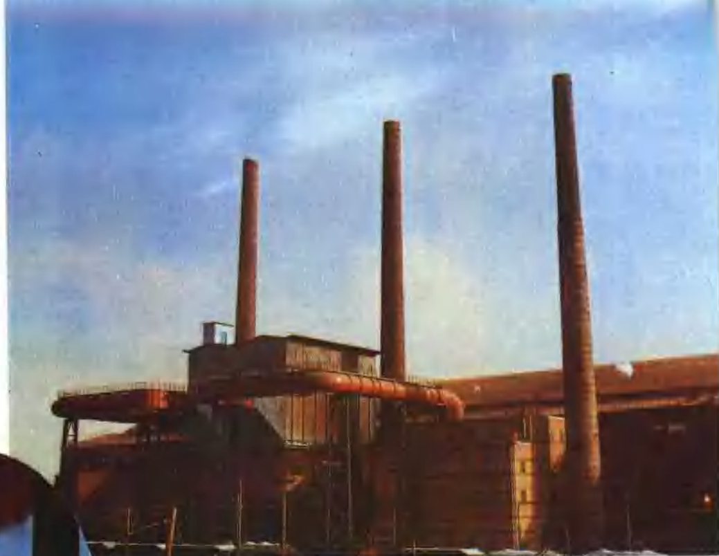
第二炼钢厂 17、18 号平炉电除尘 (左下图为未安装电除尘以前的情形)
