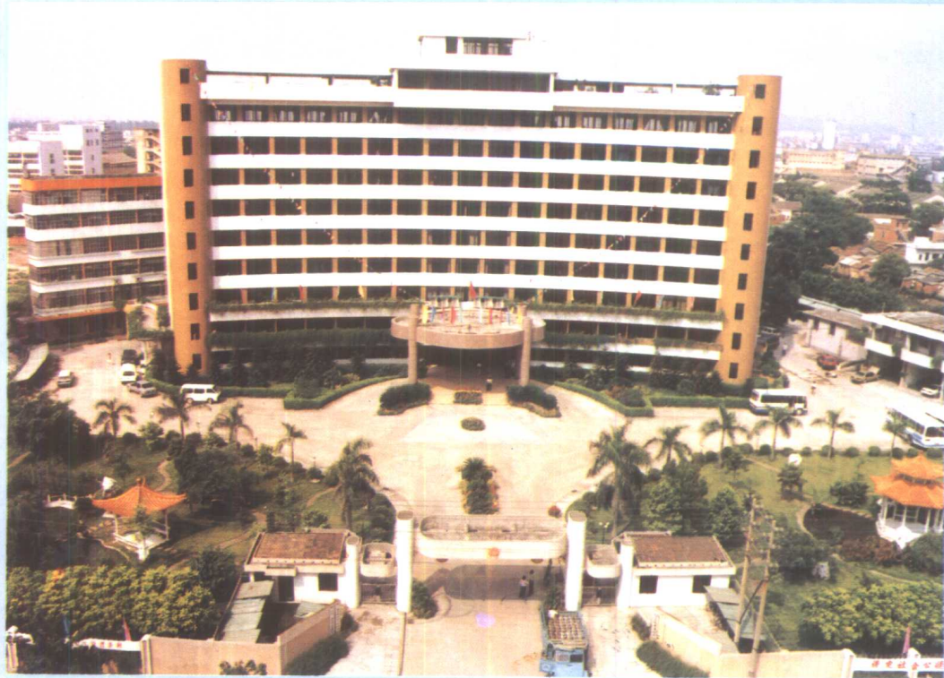
▲ 区机关大楼(芳村大道 356号)
