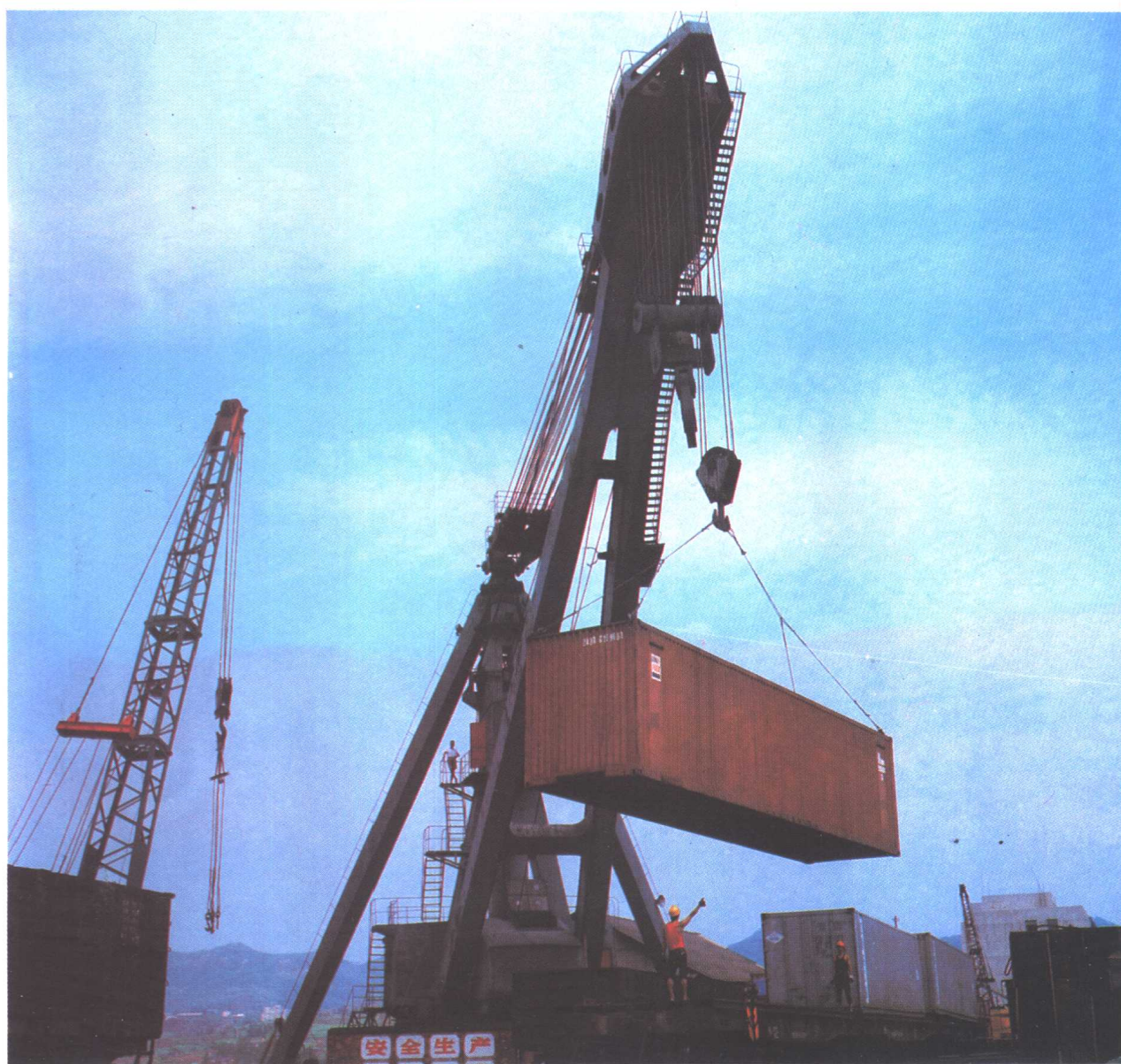
▶ 九龙坡港区重件码头100吨岸吊
