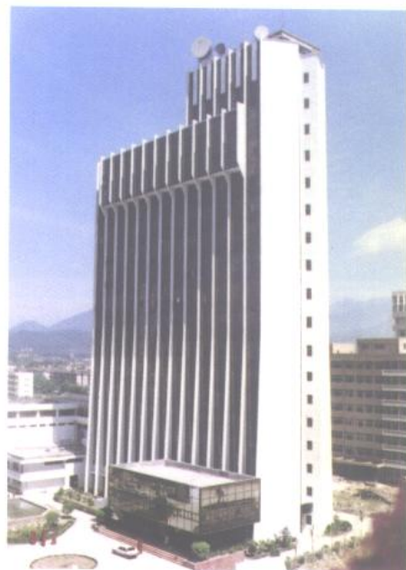
省电网中心调度所
