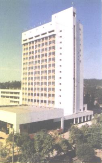
福州大学科学大楼
