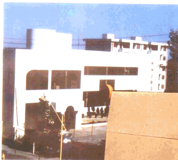
山西晉中廣源一級泵站外景
