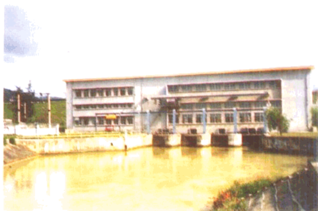
广东省东江—深圳引水工程中的泵站外景 岑以松摄
