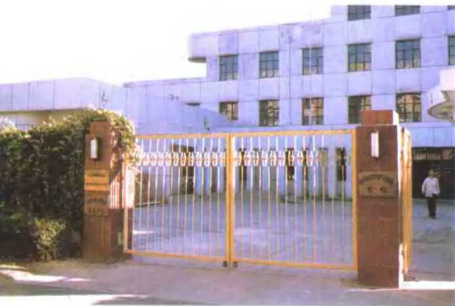
区房产总公司技工学校
