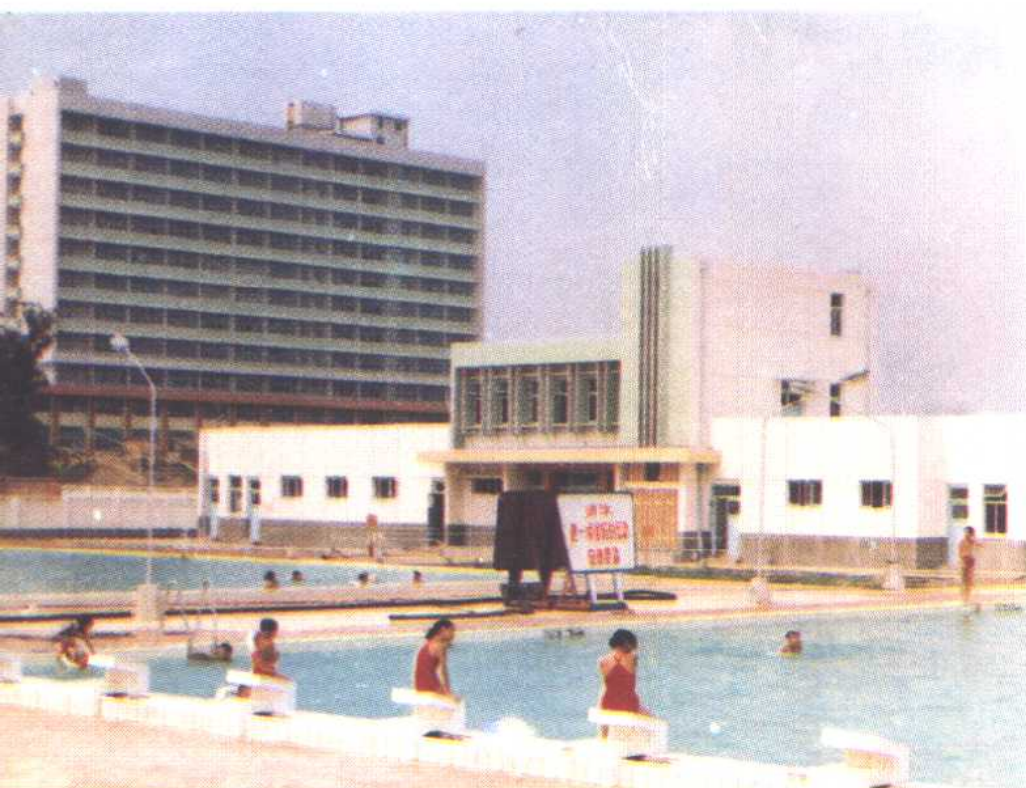
西南石油学院游泳池
