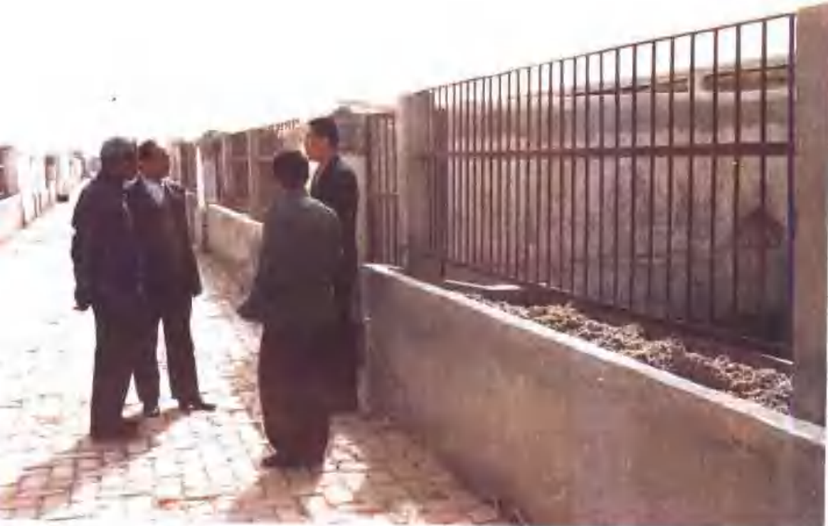
23. 养鹿工作者探讨马鹿舍前壁墙的创新改建
