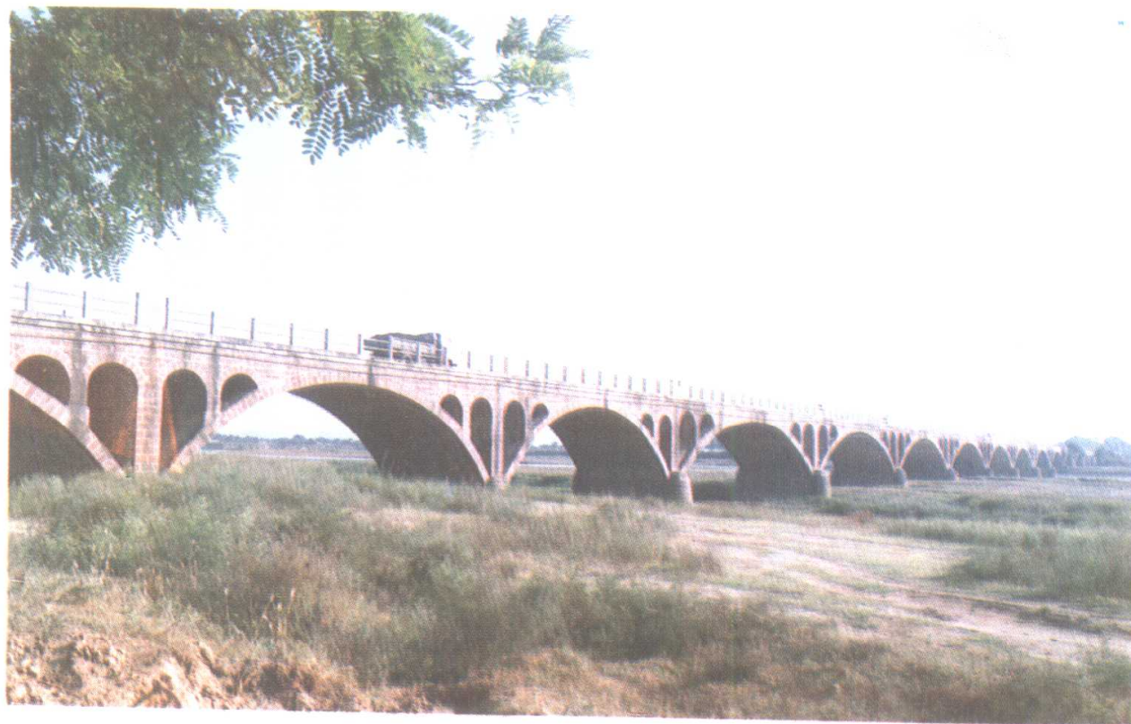
郟县汝河桥（块石混凝土拱）
