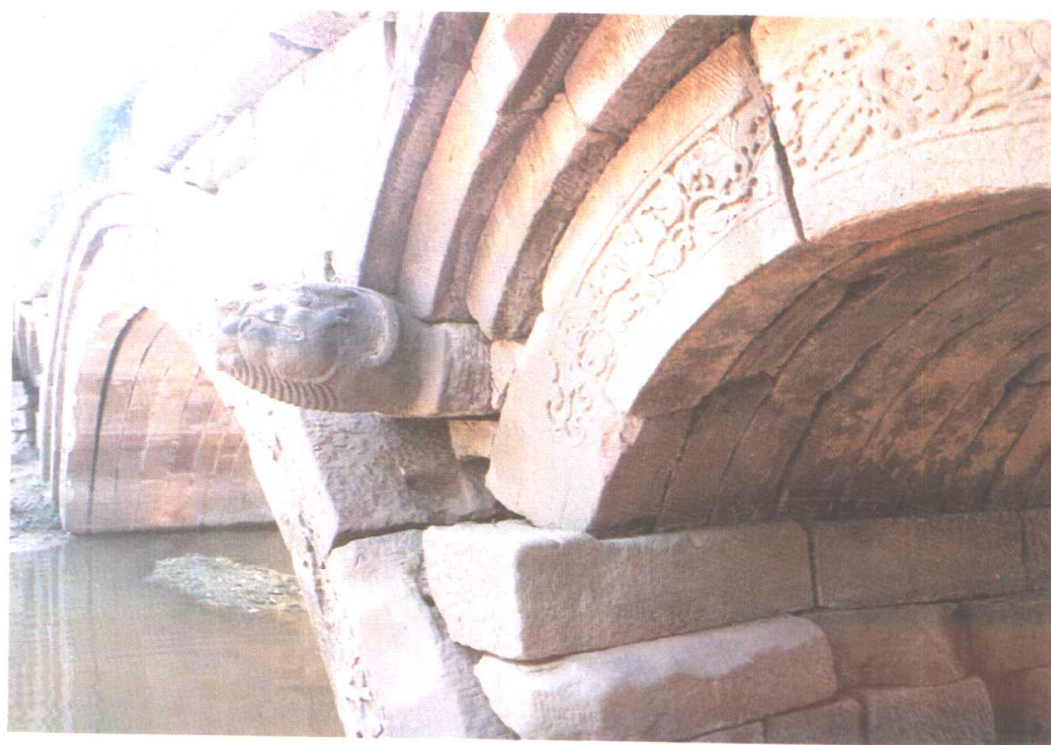
临颖小商桥（局部）
