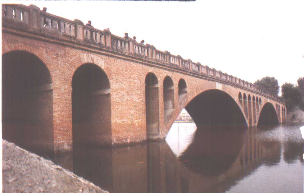
鹿邑付桥 (砖拱桥)
