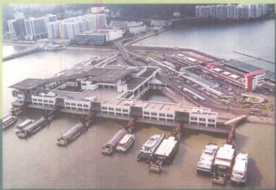
澳门港澳码头及直升機坪
