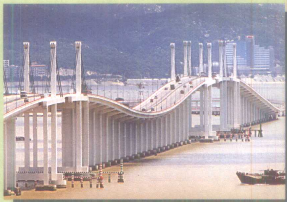
澳门第二座横跨澳氹海面的大桥——友谊大桥
