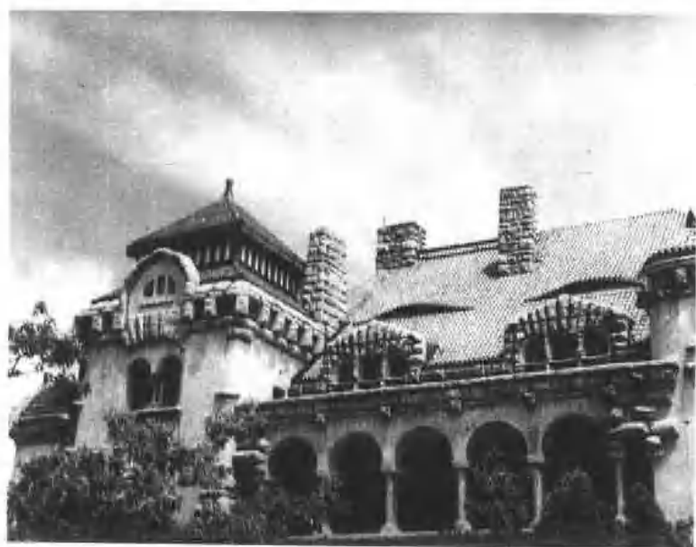
德国在青岛建造的总督楼
