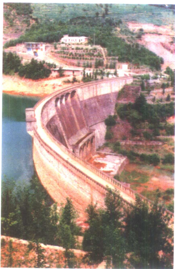
金沙县文家桥水库浆砌三心落拱坝
