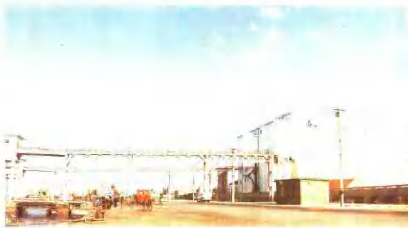
石岛万吨冷库
