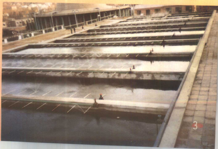
蝌蚪池(露天、砖石水泥结构加温型)
