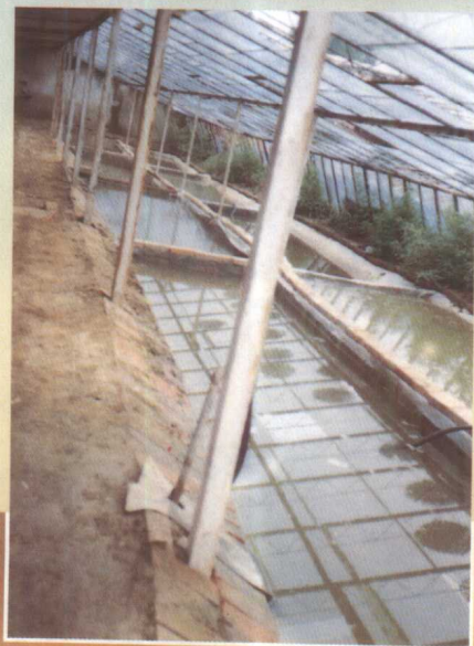
孵化池(玻璃温室、 砖石水泥结构,水面 卵团正在孵化中)
