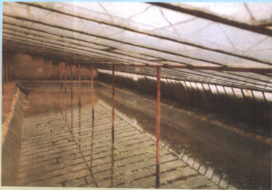
产卵池(温室、砖石水泥结构、加温型)
