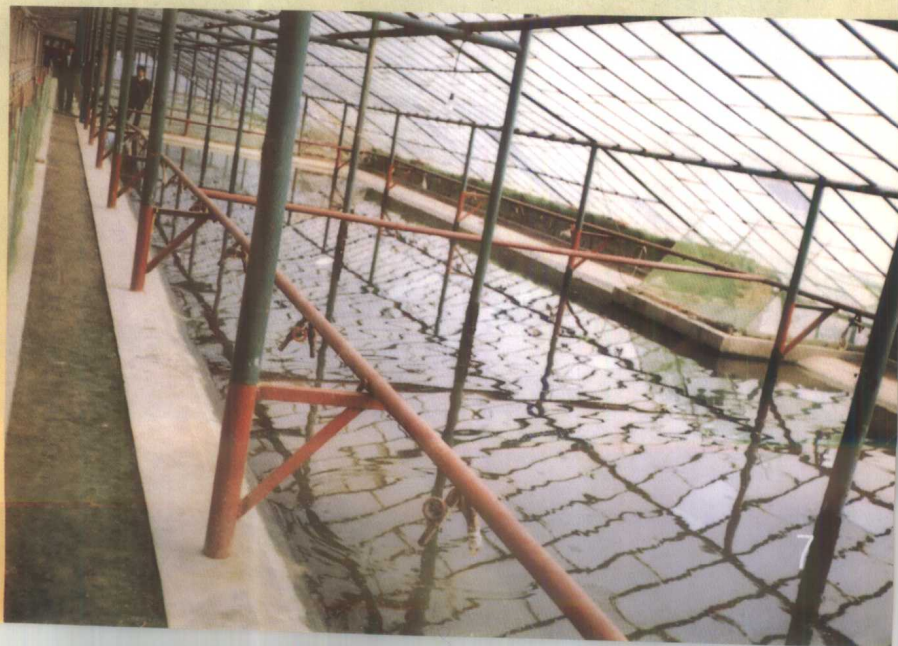
产卵池(温室、砖石水泥结构、加温型)
