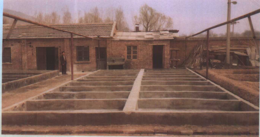
孵化池(露天、砖石水泥结构)
