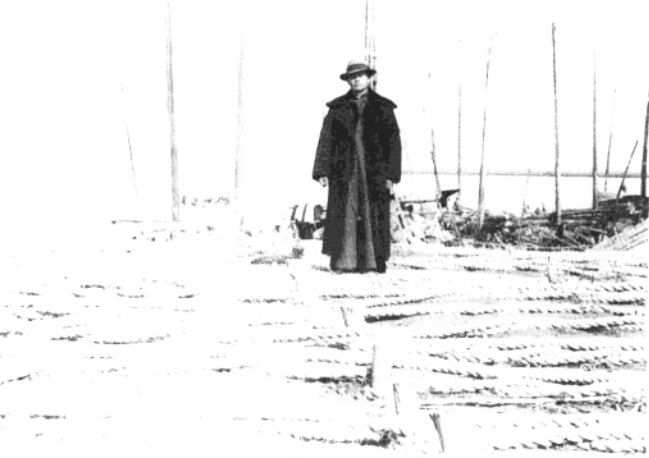
1935 年 冬，唐振绪 在黄河董庄 堵口工地上。
