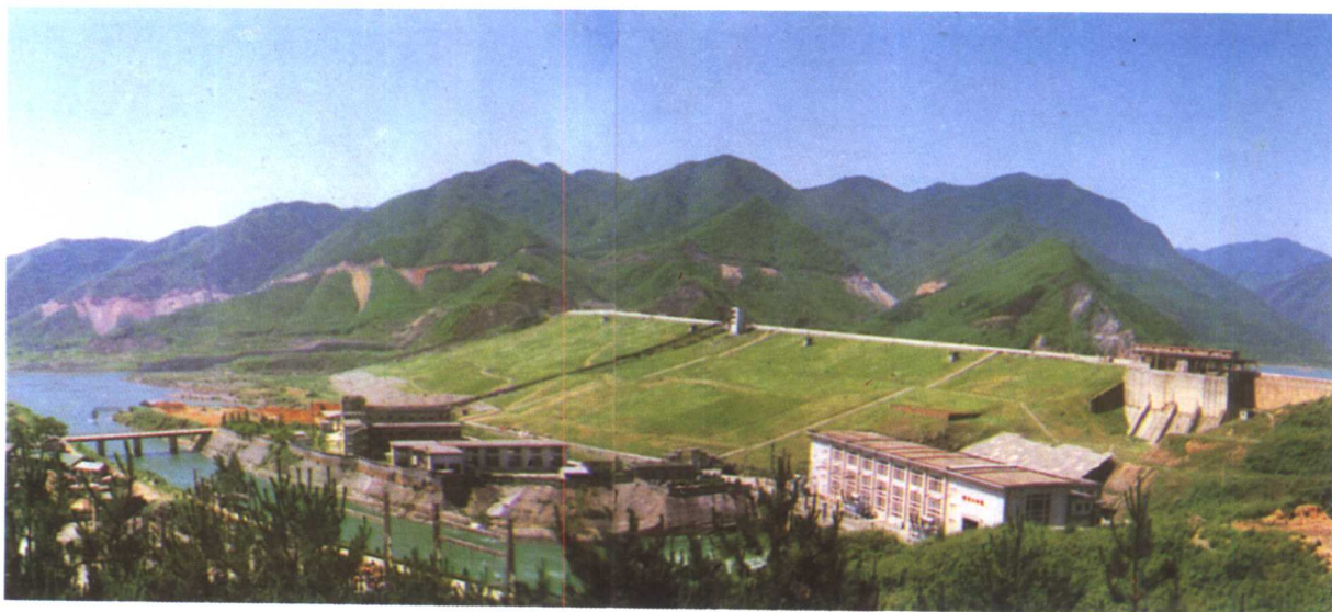
永修柘林水库大坝
