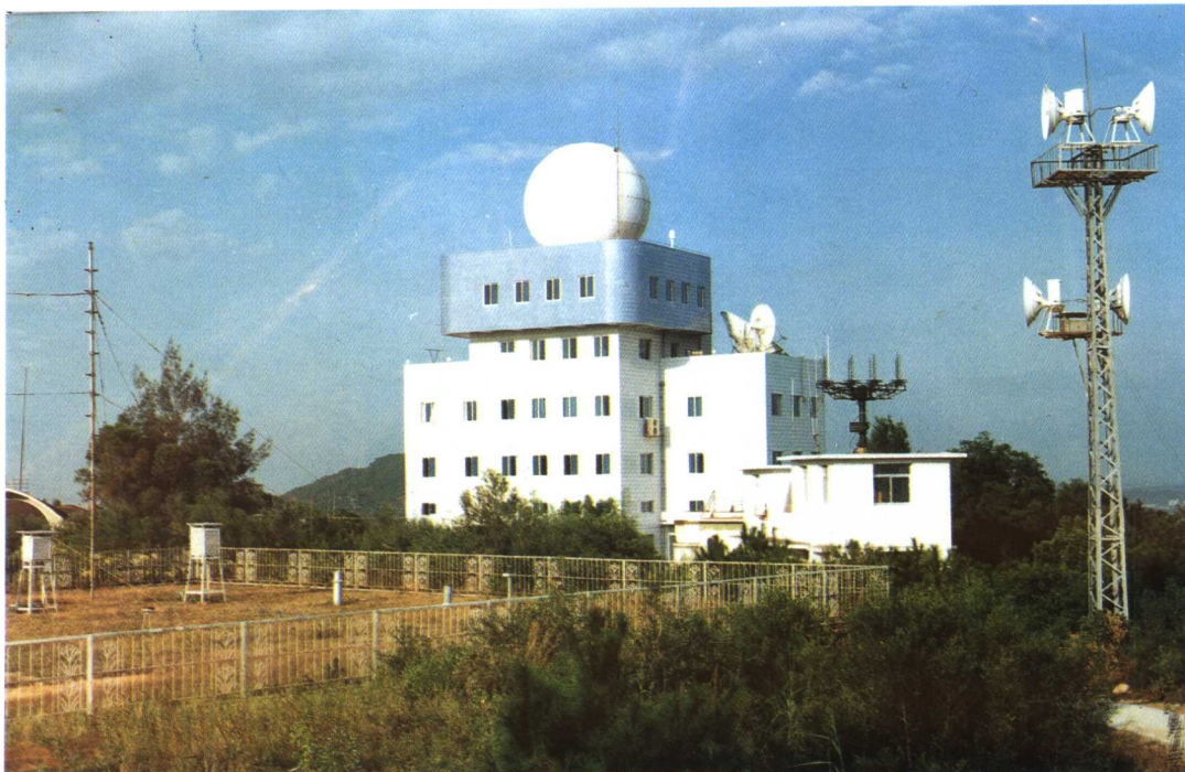
△国产 S 波段多普勒天气雷达在厦门市气象局投入业务运行
