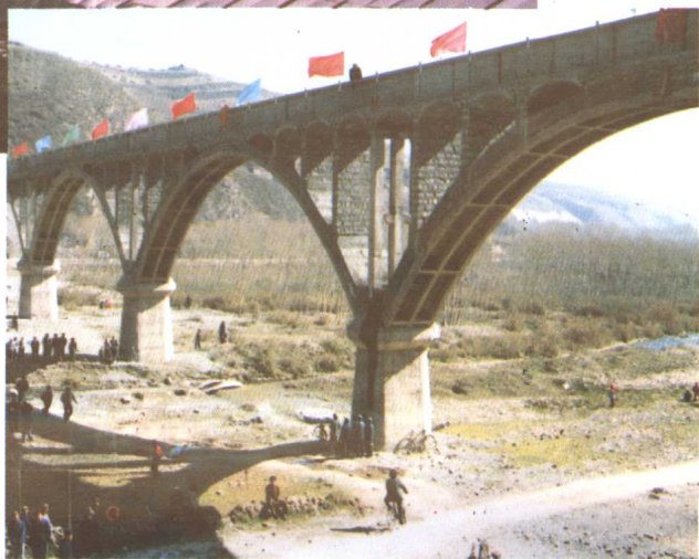
财政支农资金项目—— 互助县农业综合开发区引水 渡槽
