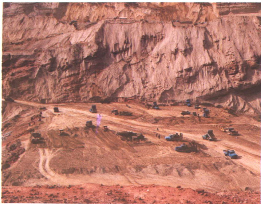
正在建设中的财政支农项目——乐都县中坝水库
