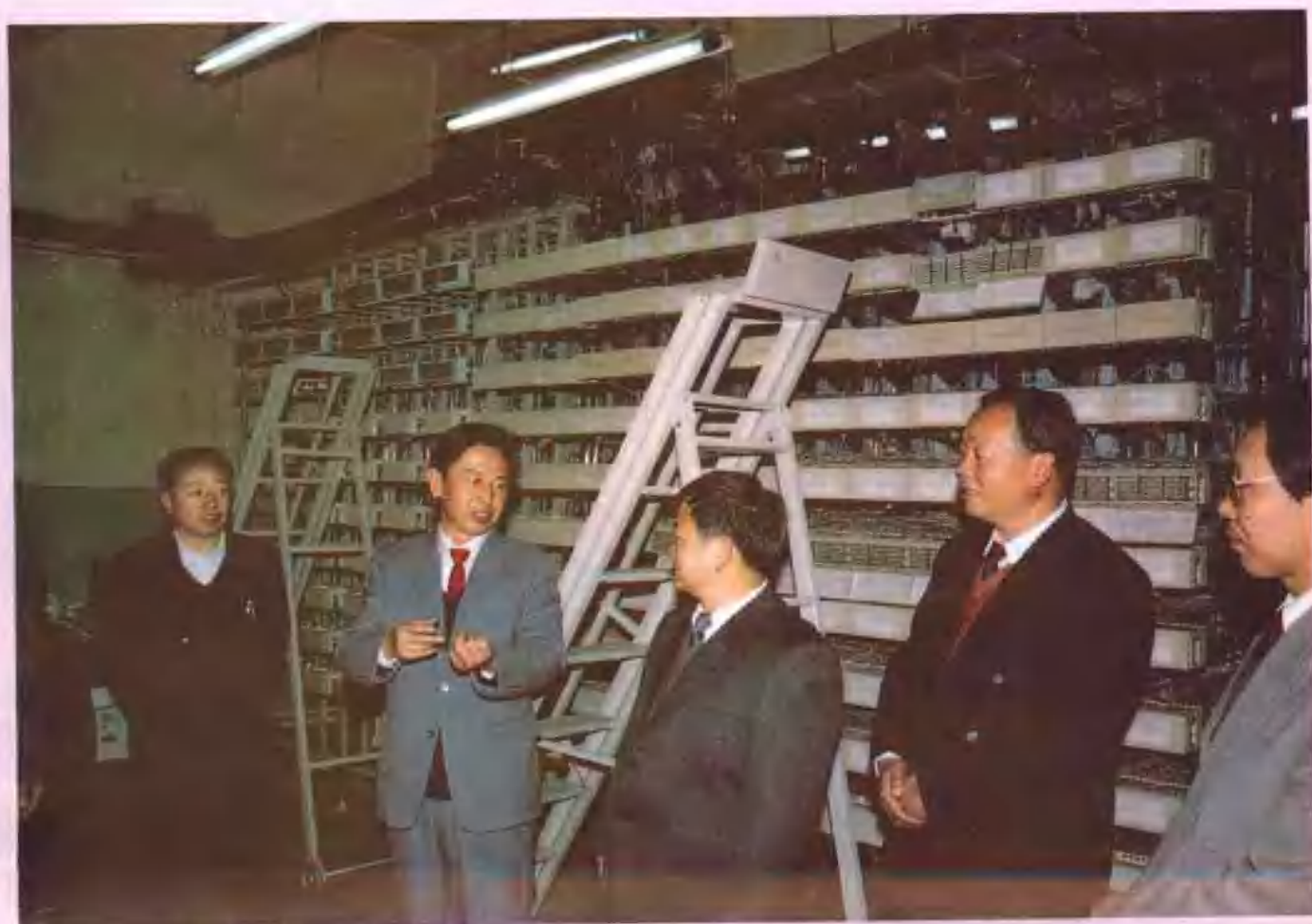
行署专员李兵、副专员黄有能检查曲靖市话扩容工程 （汤振华 摄）
