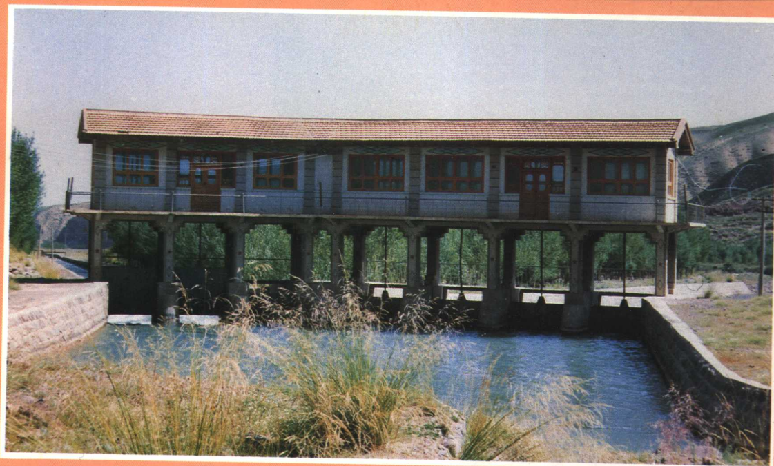
大堵麻总干渠分水闸
