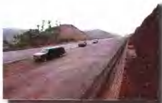
建设中的内宜高速公路
