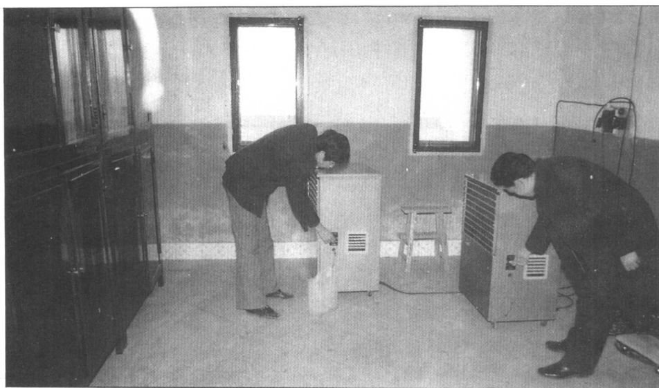
州档案馆库房采用去湿机吸湿。
