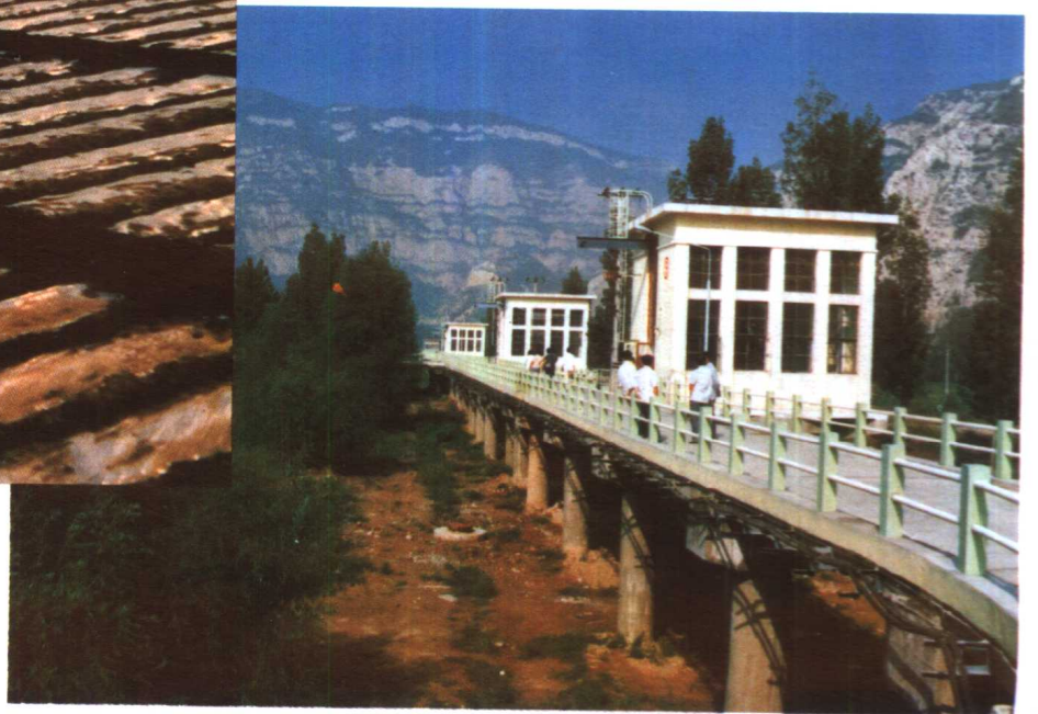
兰村水源改造工程
