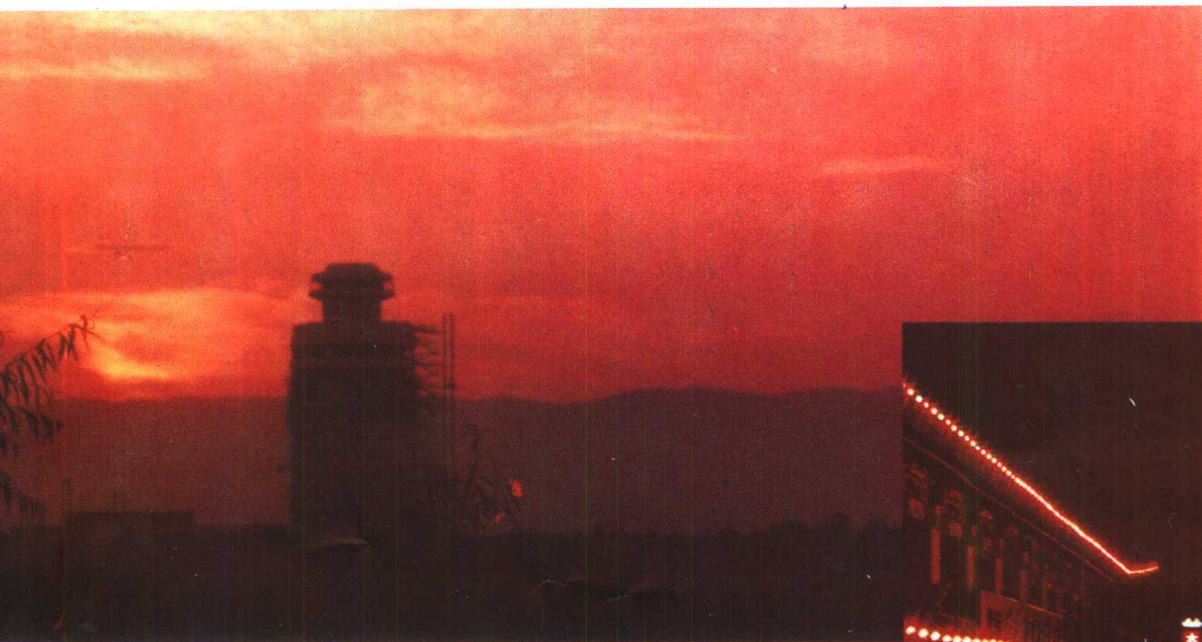
建设中的太原广播电视大楼
