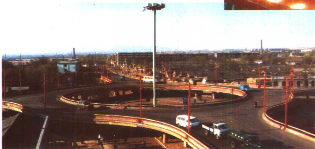
尖草坪立交桥
