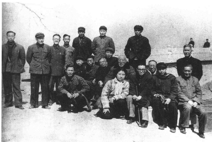
视察赵州桥维修工程，前排右三梁思成，最后排左三汪季琦
