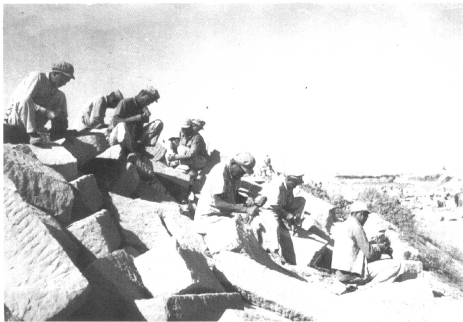
1951年,部队凿石修筑水渠。 (袁国祥摄)
