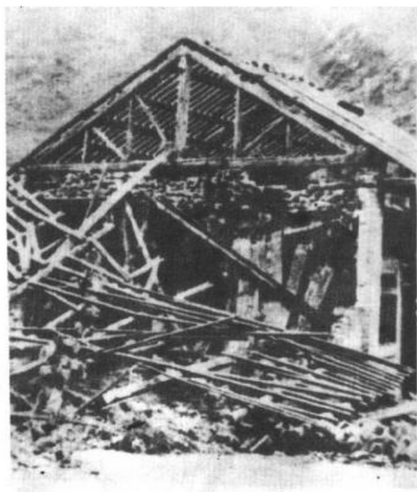
松潘地震震害
