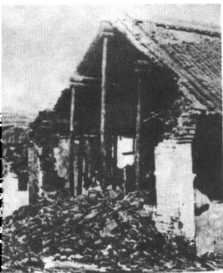
海城地震震害
