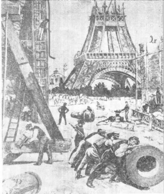
铁塔在建造中
