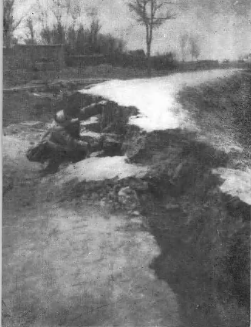
冀县阎家寨公社阎家寨滏阳河堤3月22日地 震裂缝坍塌。
