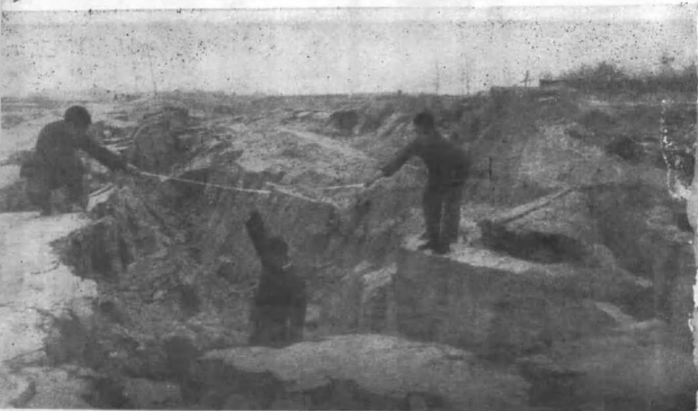
冀县阎家寨公社阎家寨滏阳河堤3月22日地 震裂缝坍塌。
