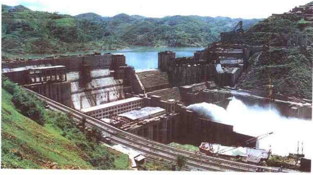
安康水电站一号机组 并网发电
