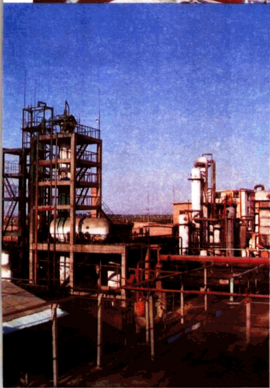
贺兰县化肥厂厂景
