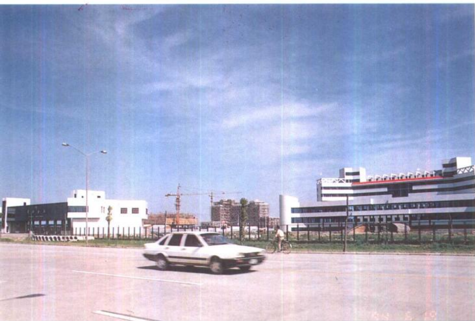
占地4.1平方公里的张家港保税区已初具规模。图为保税区内的雄伟建筑和热气腾腾的建设工地。
