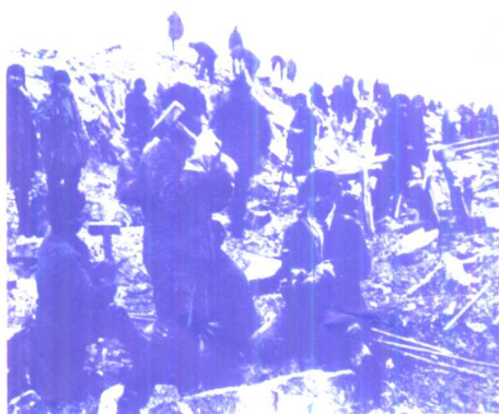
在利菲内河建造纳粹占领区的隧道
