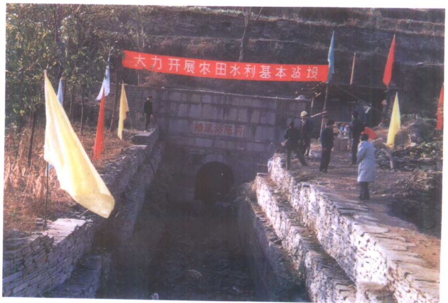
水库干渠正在进行岁整修
