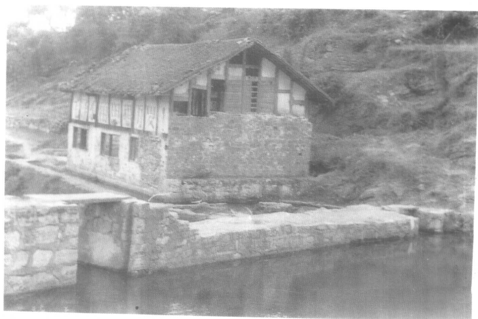
一九五六年兴建的贵阳最早的 农村水电站——云锦电站旧址
