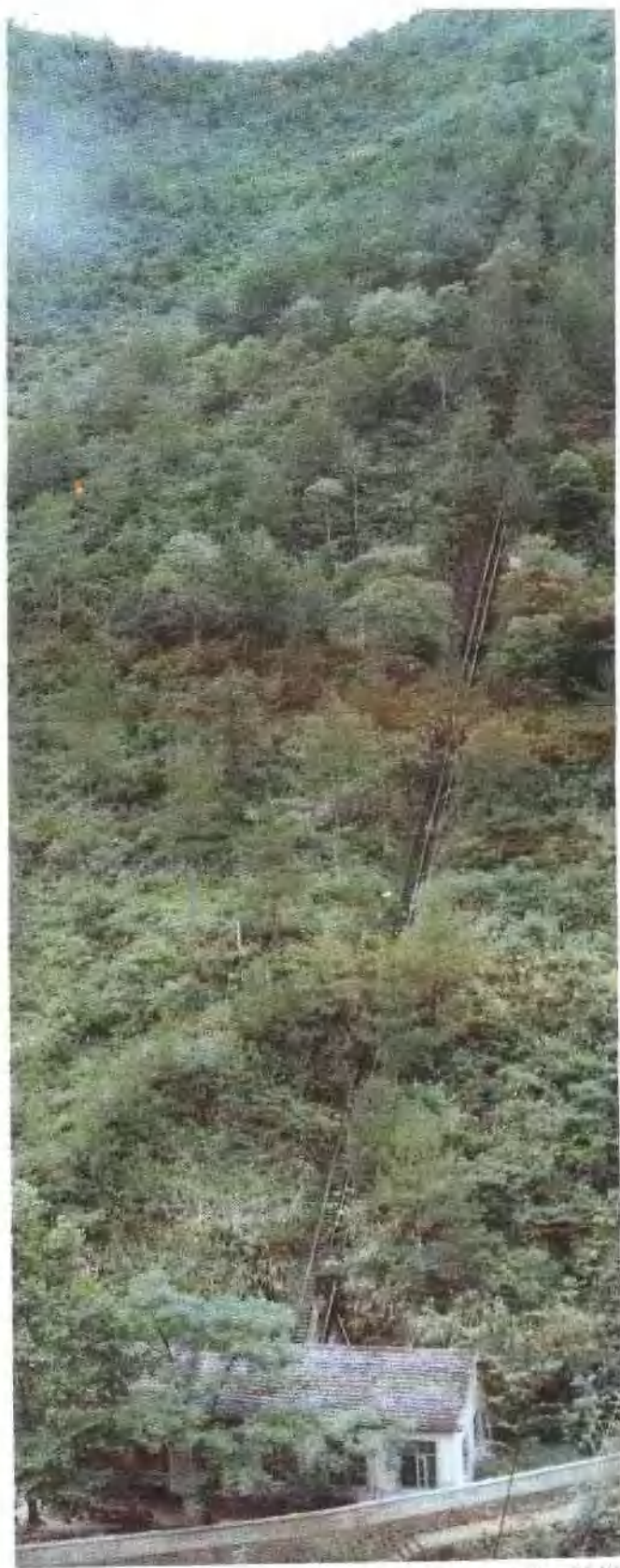
石塘坑一级水电站。设计水头 185 米，装机 1140 千瓦。1971 年建成。
