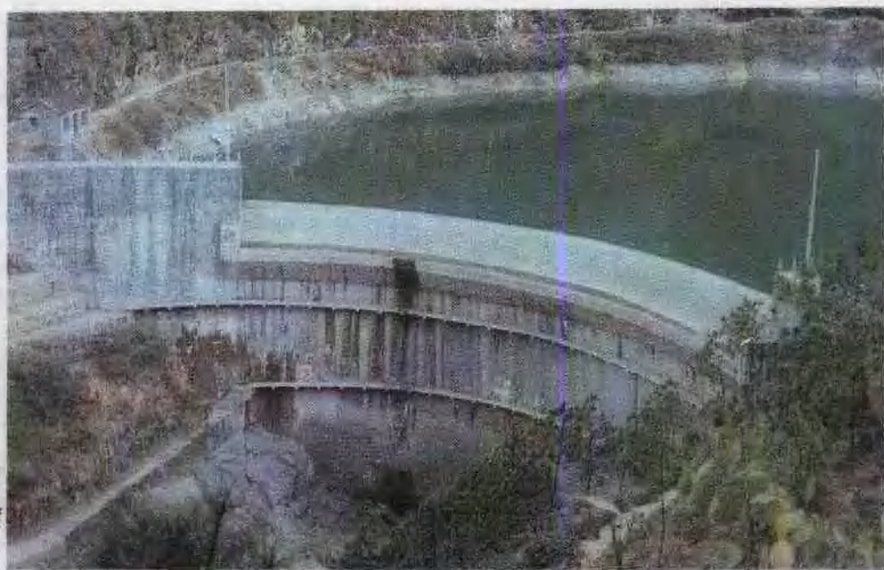
泗洲堂水库。双 曲拱坝高 29.2 米，蓄 水量 103 万立方米。
