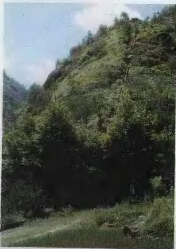
蓉吼水电站。乡办。设计水头 64 米,装机 200 千瓦。1979 年建成。
