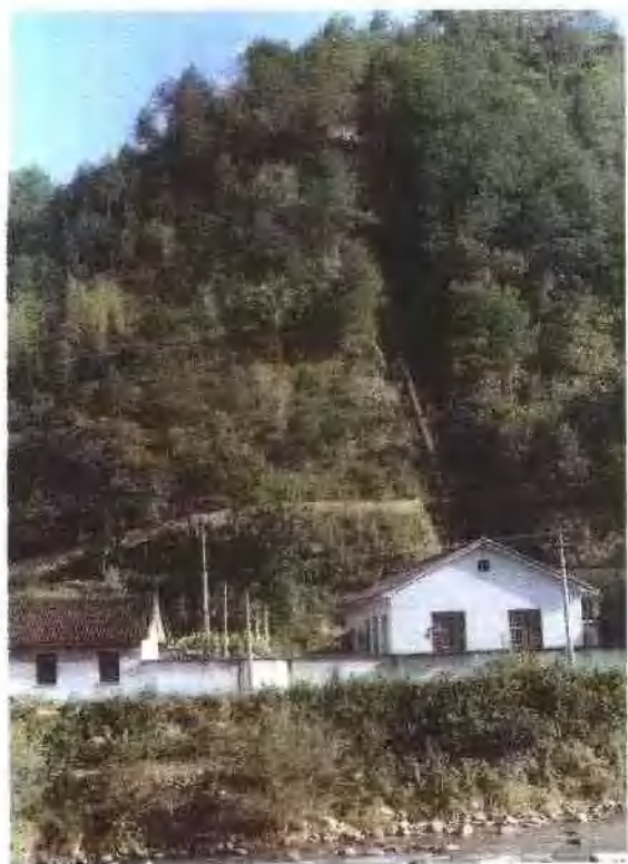
村头水电站。设计水头 70 米，装机 960 千瓦。1966 年建成。
