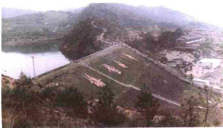
梅塋水库。坝高 26 米,蓄水量 260 万立方米。坝外左侧为县自来水厂。
