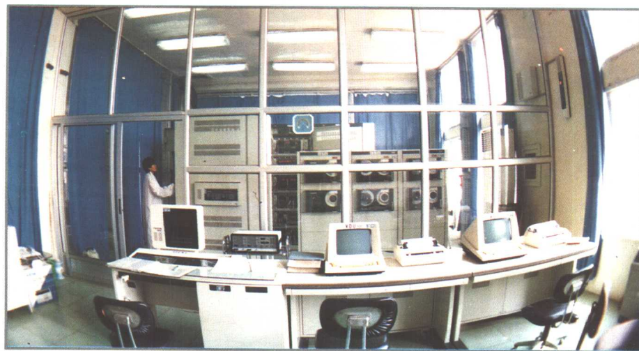
贵阳市电信大楼的TS 长途程控交换机房。
