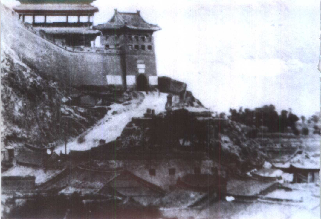
潼关东城门楼外景
