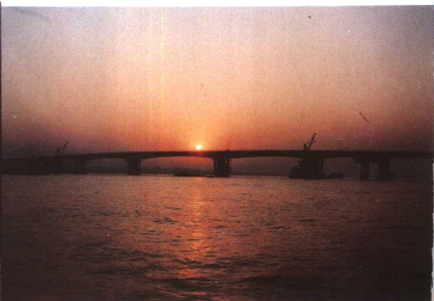
扬中人民自筹资金 1.52 亿元建 成全长 1168 米的扬中长江大桥
