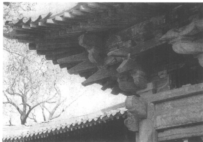
第八图 隆兴寺摩尼殿南面抱厦下檐转角铺作
