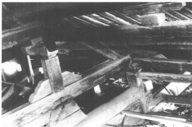
第四图 隆兴寺摩尼殿四椽栿上构架
