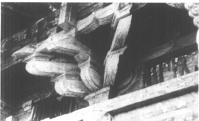
第九图 隆兴寺摩尼殿南面抱厦下檐柱头铺作
