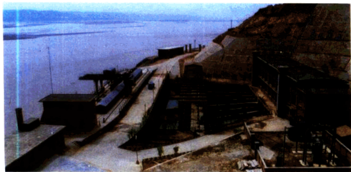
照片1 陕西东雷一级泵站渠首进水闸
